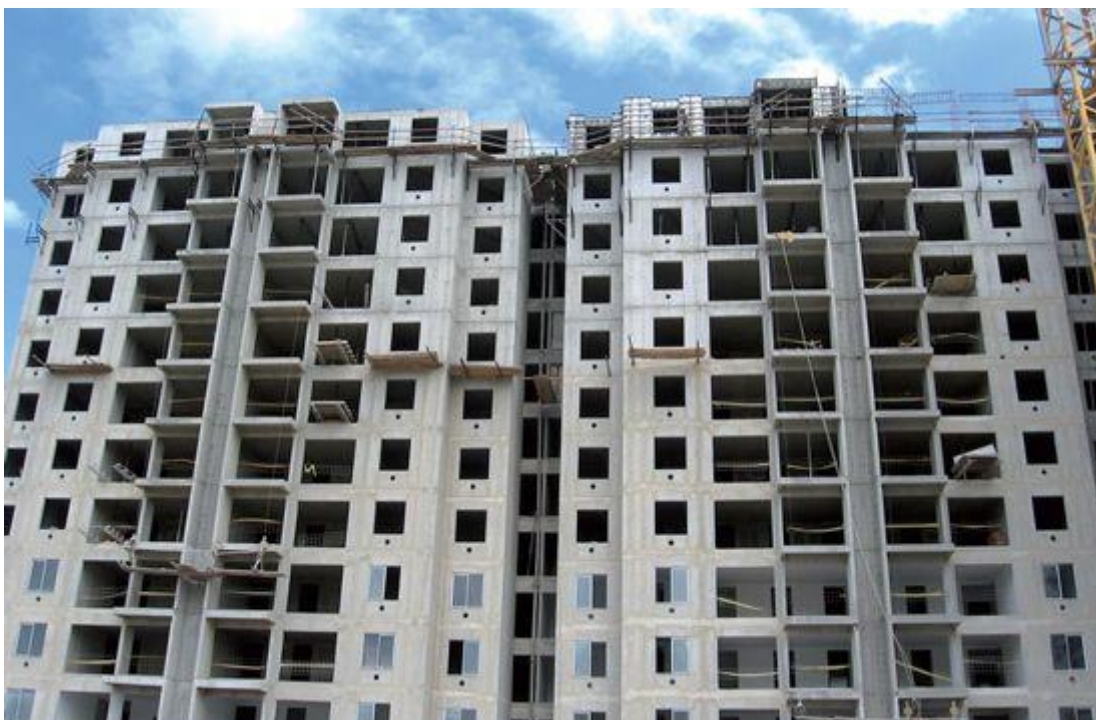
NBR 16055:2012 contempla aspectos de dimensionamento e execução do sistema de paredes de concreto moldadas in loco, que ainda não era normatizado, apesar de ser usado há cerca de 30 anos no Brasil
