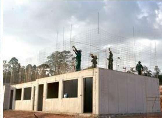
Dependendo do projeto, pode ser usada uma tela centralizada ou duas telas, nas extremidades
