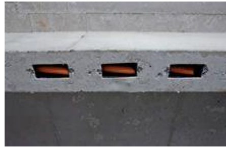
Planejamento apurado é essencial para a execução de edifícios com paredes de concreto, pois os elementos de elétrica ficam embutidos e devem ser posicionados antes do lançamento do concreto
